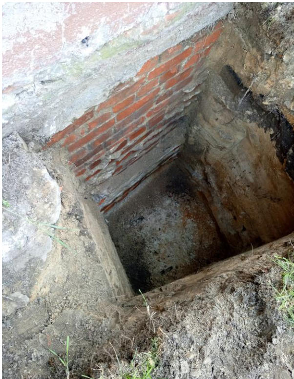
Fot. 7, 8 Widok wykonanych odkrywek zawilgoconych ścian fundamentowych
