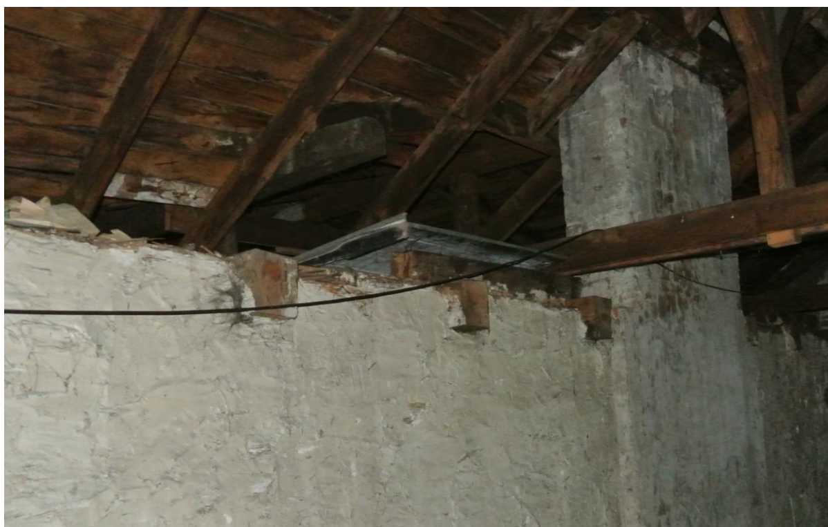
Fot. 17 Widoczne ślady zacieków na deskach poszycia dachowego najprawdopodobniej wskutek braku odpowiedniego przewietrzania przestrzeni poddasza przy szczelnym pokryciu z blachy na której kondensuje się para wodna; widoczne w wielu miejscach pokrycia dachowego na deskach oraz w szparach między deskami ślady białej pleśni z klasy workowców (Ascomycetes) i grzybów (Deuteromycetes) charakterystycznych dla korozji biologicznej w tego typu przypadkach
