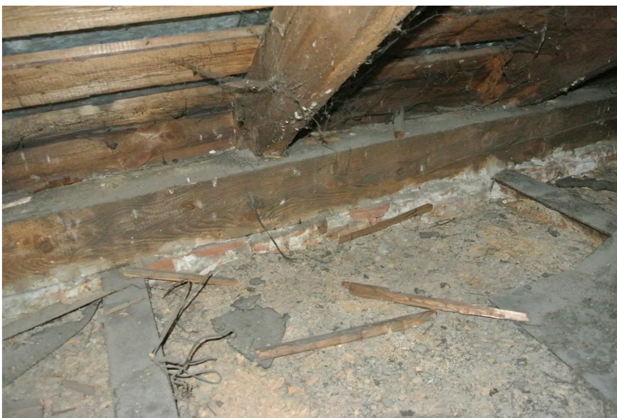
Fot. 15 Widok półek dwuteowych belek stropu poddasza z przestrzeni poddasza – widoczne oparcie krokwi dachu na belce podwalinowej oraz zasypka z trocin i wapna na płytach stropu między belkami
