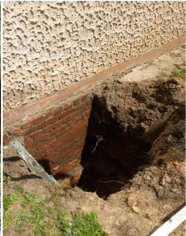
Fot. 7, 8 Widok wykonanych odkrywek zawilgoconych ścian fundamentowych
