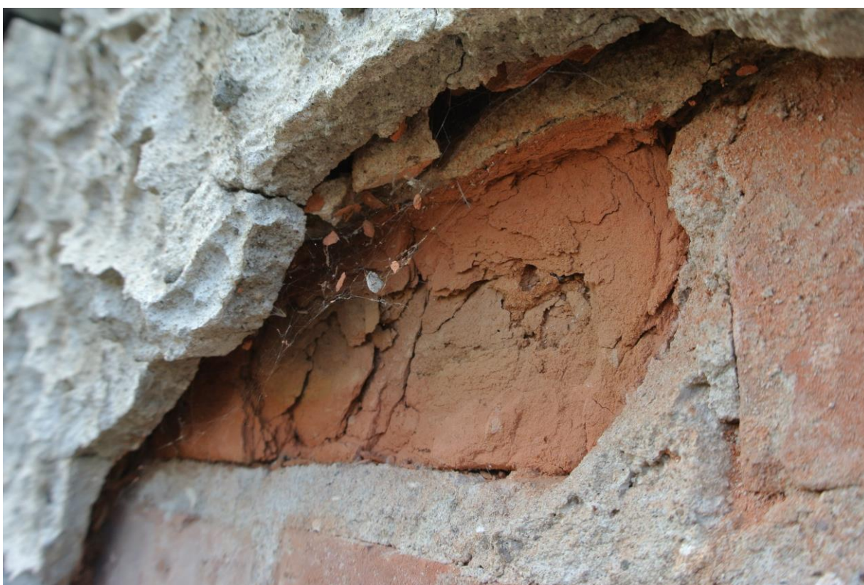
Fot. 11 Detal uszkodzenia mrozowego - widoczne początki rozsądzenia zamarzającą wodą cegły w ścianie
