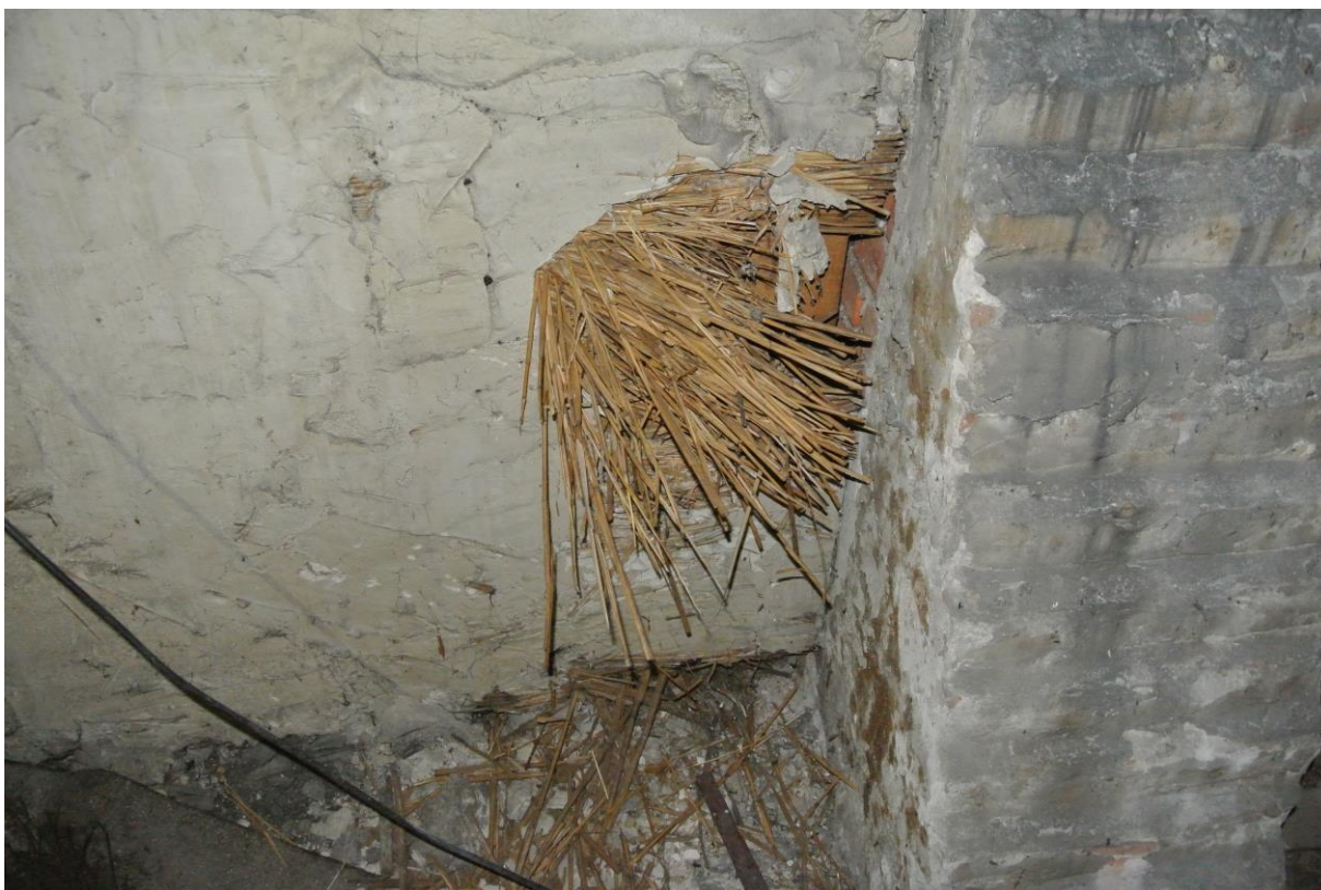
Fot. 19 Przykład ocieplenia ścianki na poddaszu matą słomianą z obrzutką z zaprawy wapiennej
