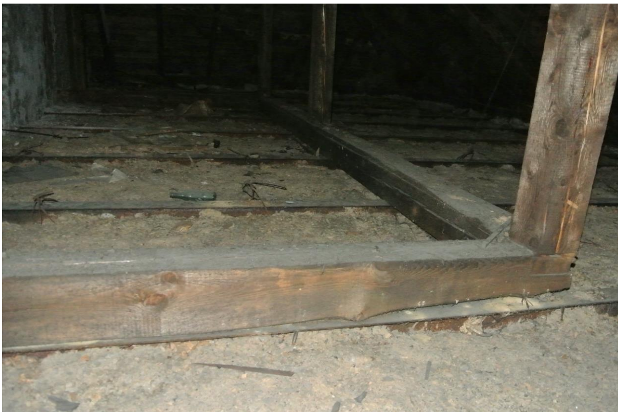
Fot. 16 Widok oparcia słupów więźby na dwuteowych belkach stalowych stropu poddasza
