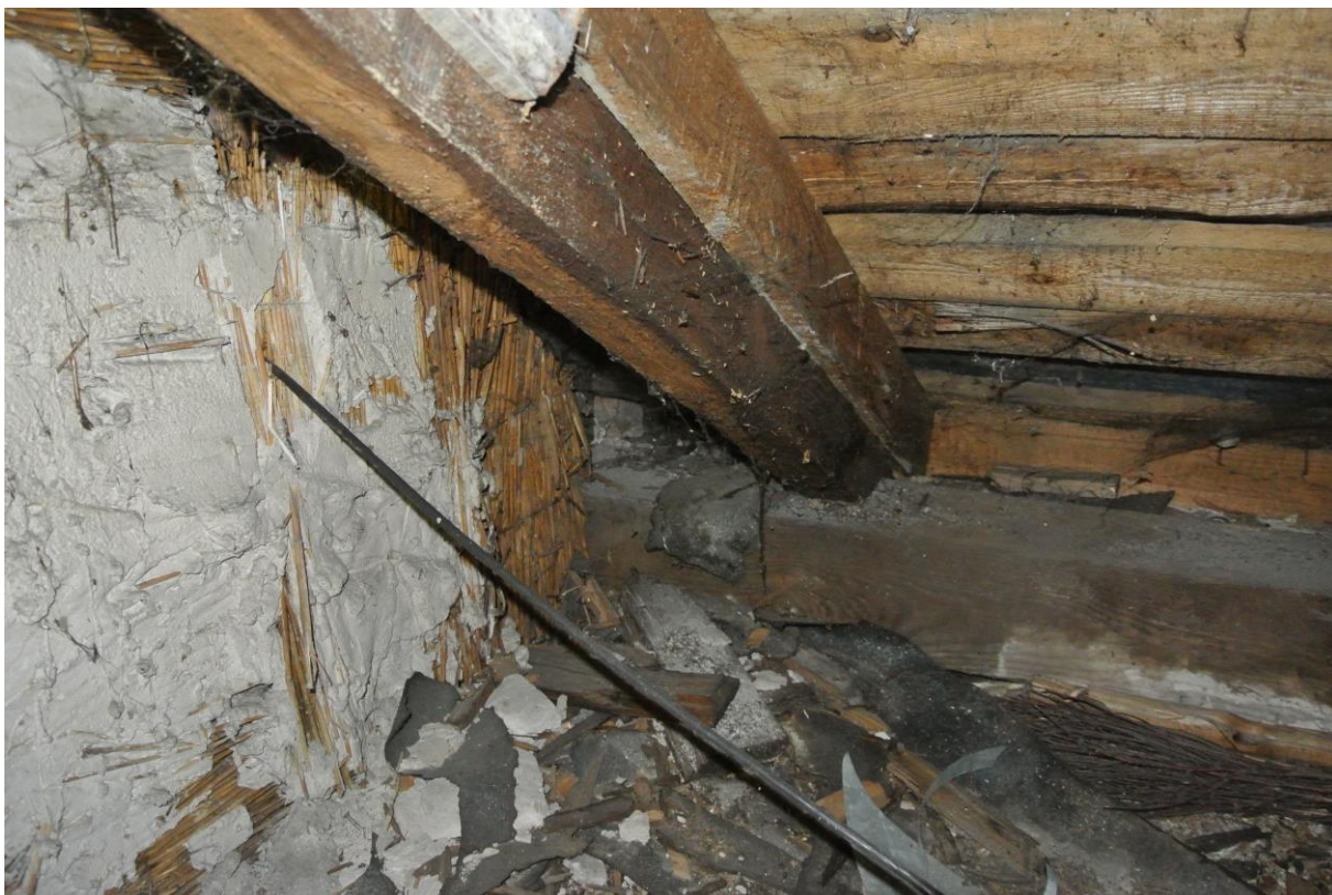
Fot. 20 Kolejny przykład stwarzającej zagrożenie pożarowe ścianki działowej ocieplonej słomą z obrzutką z zaprawy wapiennej
