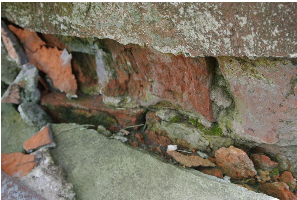
Fot. 12 Detal uszkodzenia mrozowego - widoczne rozsadenia zamarzającą wodą cegieł w ścianie na styku z opaską przyścienną oraz omszenie uszkodzonych cegieł
