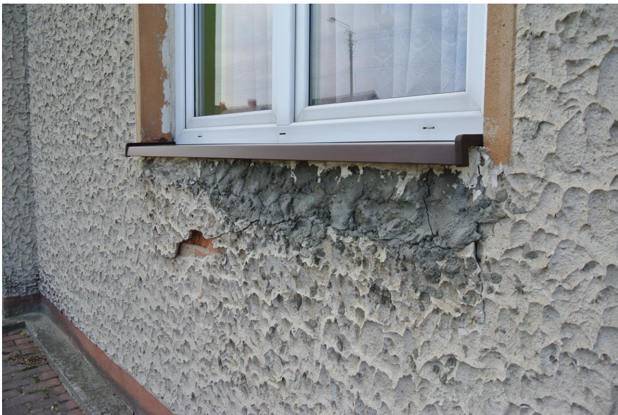
Fot. 10 Nieskuteczne próby naprawy tynku na uszkodzeniu mrozowym
