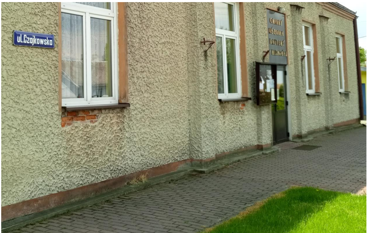
Fot. 9 Widoczne mrozowe uszkodzenia tynku w miejscach pod parapetami, gdzie ścieka woda z okien dodatkowo nawilżając zamokniętą od podsiąkającej wody północną ścianę elewacyjną; widoczne omszenie nasiąkniętej wodą opaski przyściennej oraz chodnika
