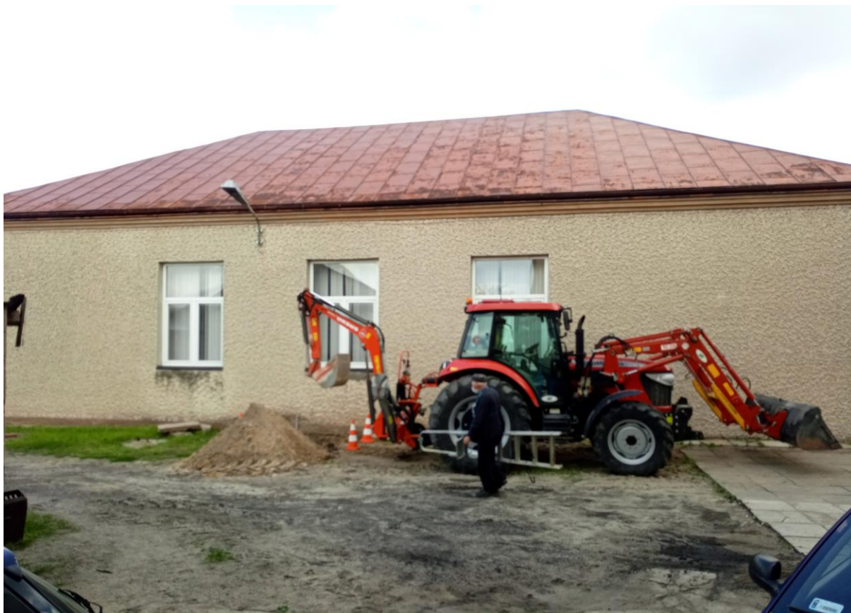
Fot. 5 Wykonywanie odkrywek ściany fundamentowej przy tylnej elewacji budynku
